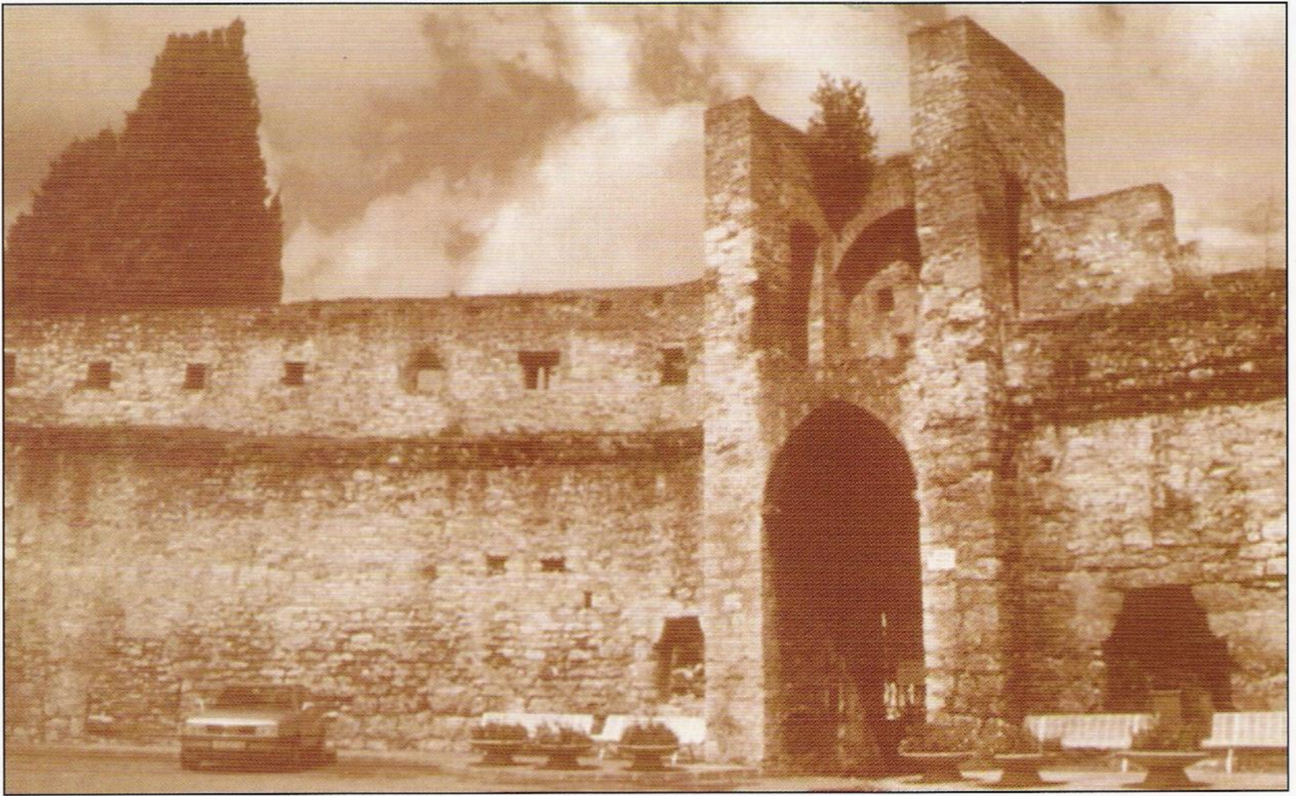
Interior de la Porte St Michel en Cahors, una típica fortificación urbana del siglo XIV. (Foto del autor)
